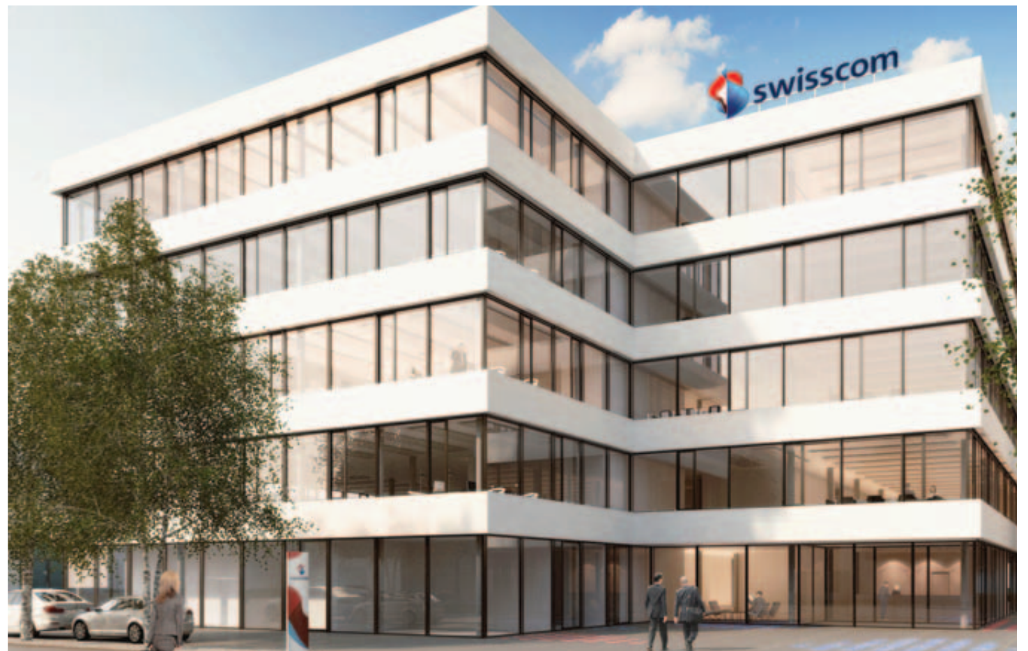
Le premier coup de pioche sera donné la semaine prochaine et les travaux devraient être achevés d'ici un an et demi. DR
