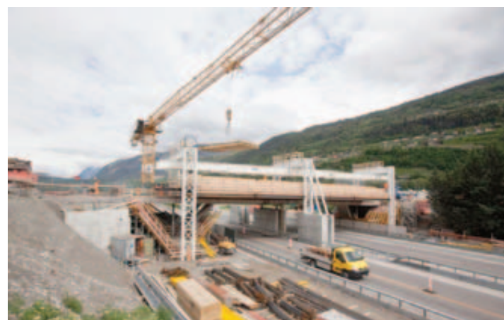
400 tonnes de béton vont être abaissées d'1,7 mètre mercredi soir. DR
